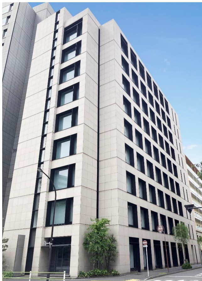
「エンスuite御成門」 (リノベーション前の既存ビルの外観)
