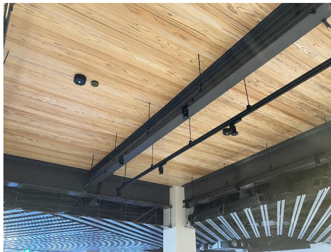
▲公園施設天井デッキ
